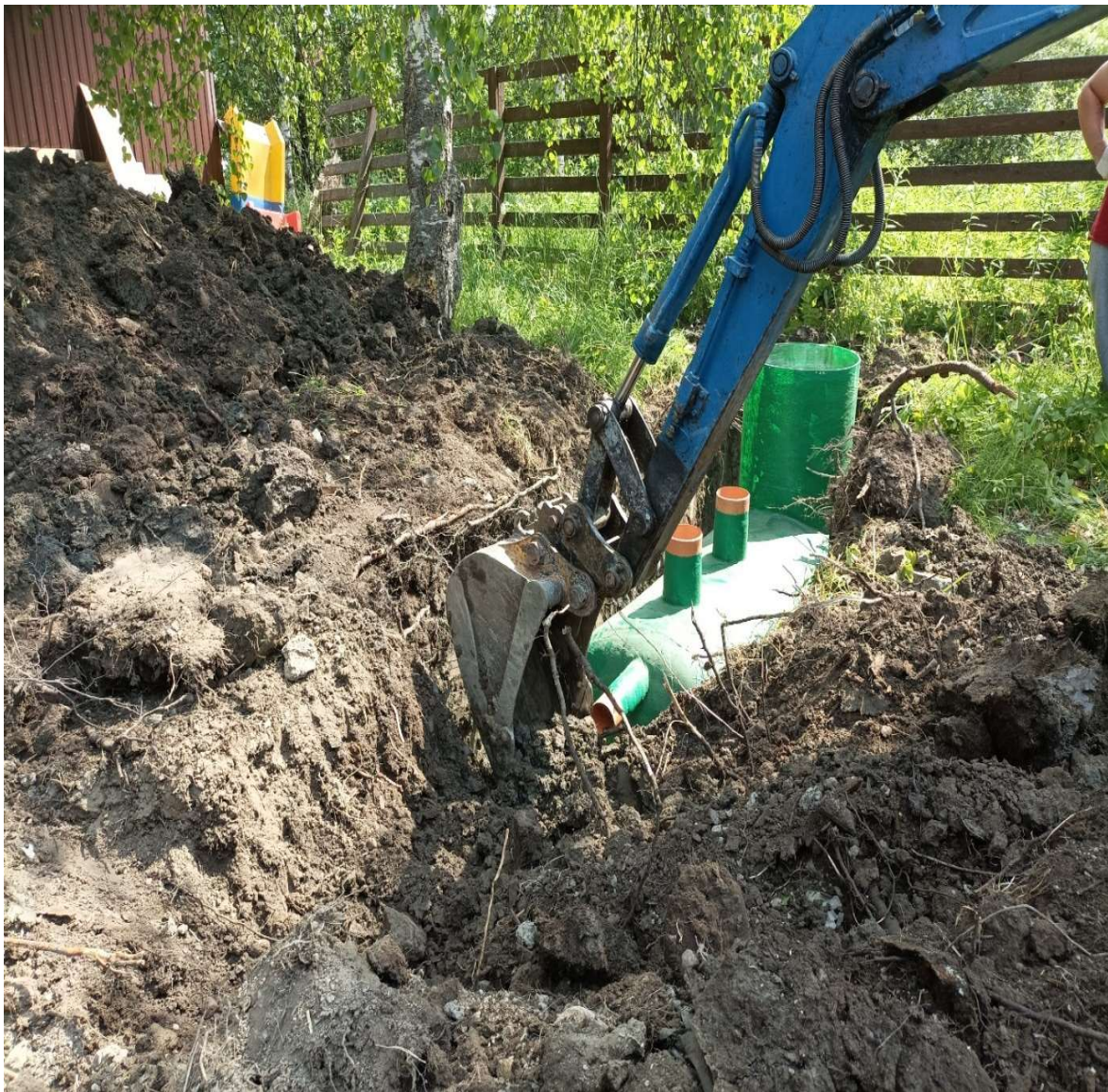
Kuva 2 Pekka Jauhiainen Kirkon laajennusosan perustukset ja viemäröintiä rakennettiin kesäkuussa 2023.
