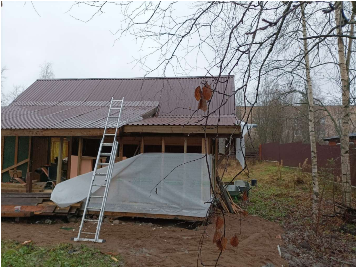
Kuva 3 Pekka Jauhiainen Kirkon laajennusosan seinät ja peltikatto rakennettiin marraskuussa 2023.
